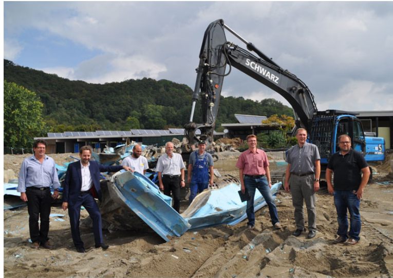
Spatenstich im Höhenfreibad Gottmadingen
